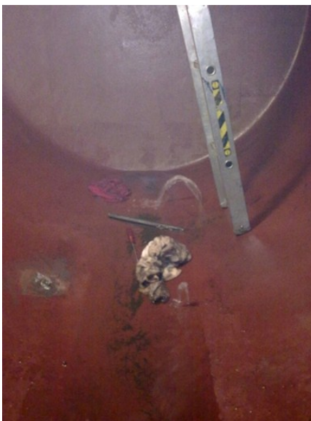
korrodierter Tank (Wassereintritt)
